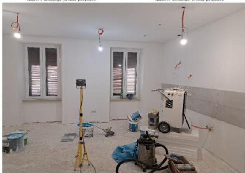
Radovi uređenja prema projektu
