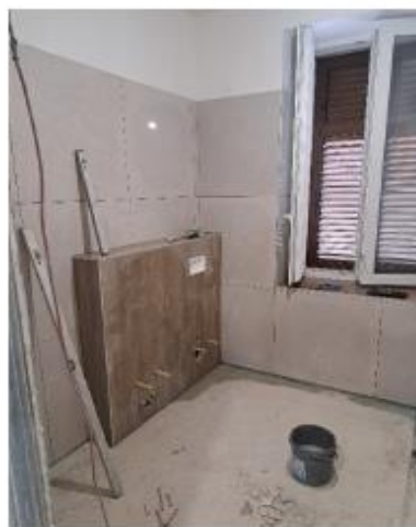
Radovi uređenja prema projektu
