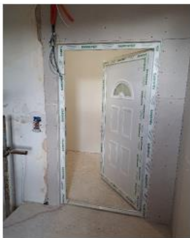
Radovi uređenja prema projektu
