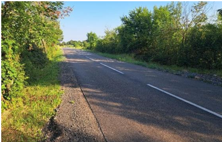
Nastavak asfaltiranja prema Marušićima
