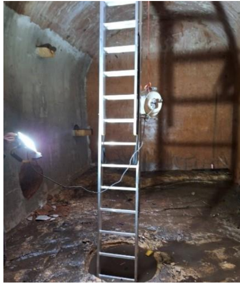
Sanacija unutrašnjeg djela
