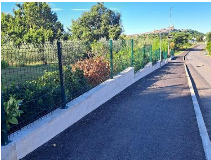
Nastavak asfaltiranja prema Marušićima
