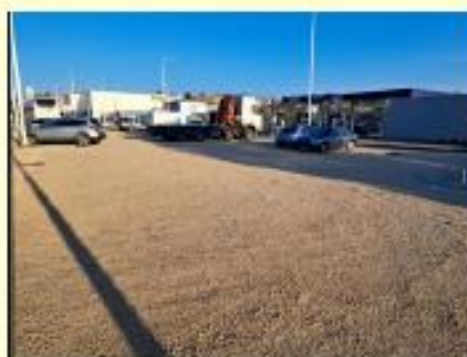
1. faza izgradnje parkinga
