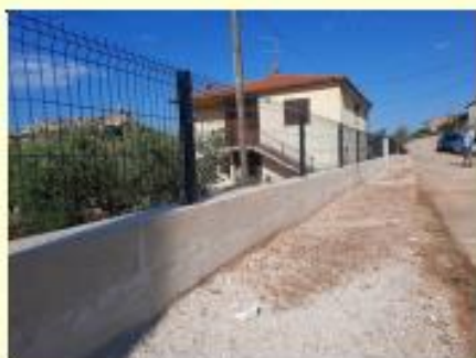
Potporni zid - Klesarska na DC 200
