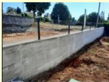
Potporni zid - Klesarska na DC 200
