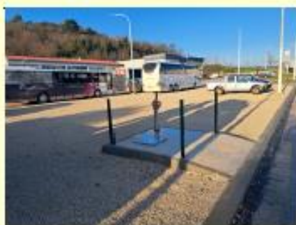
1. faza izgradnje parkinga
