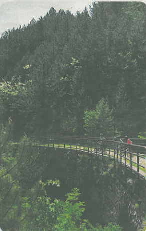
Uskotračna pruga zanimljiva je zbog vijadukta i tunela
